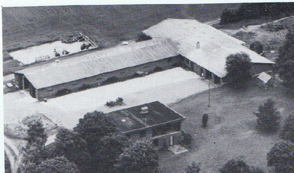
Foto: Kastrup Luftfoto.
